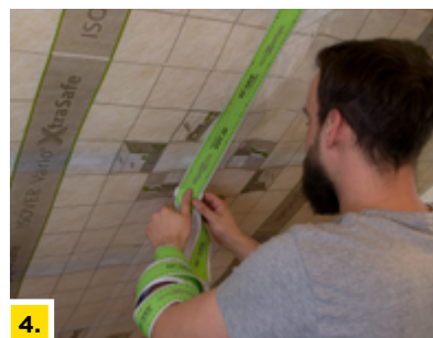
4. Zaklejenie zakładów folii taśmą połączenia typu „rzep”
